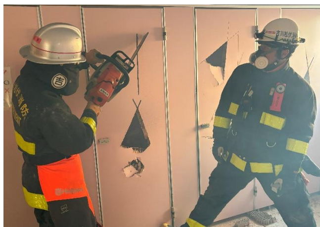
・ドアを切断し、開口部を設定している様子
